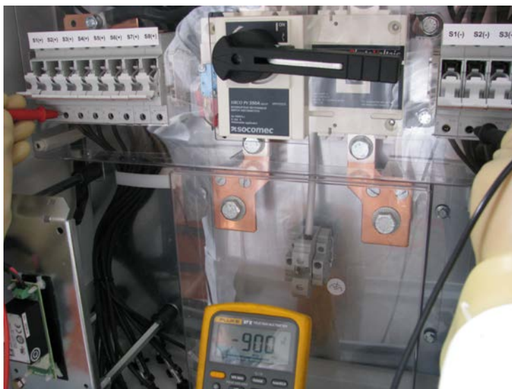
Figura 23 Punti di misura della tensione ai capi delle stringhe (verifica della stringa 2: stringa invertita!!!)
