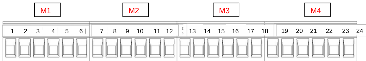
Figura 137: Morsettiere segnali ingresso-uscita
